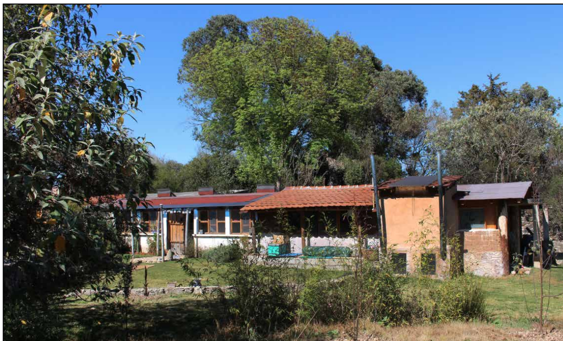
Casa Gaia Sana con baños secos, construida con pacas de paja, adobe, pajareque y teja
