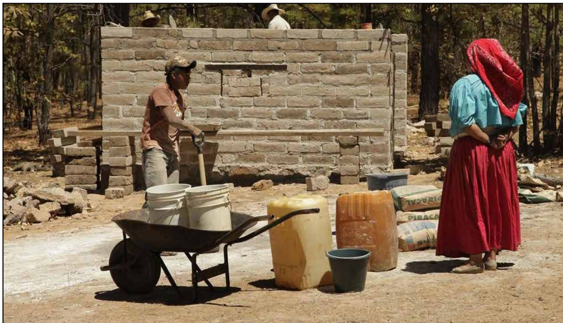
Los miembros de la comunidad trabajando en la construcción del horno solar
